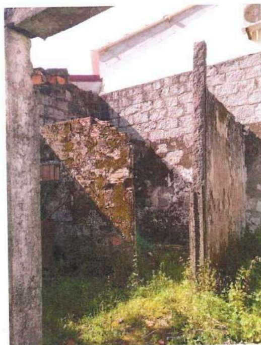
Imagem 4 – Foto da edificação, onde é visível parte do interior colapsado, bem como a cobertura.
